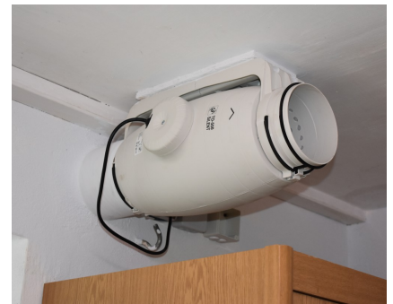
Zuluftventilator freiblasend
