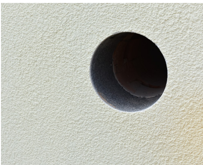
Kernbohrung Zuluft durch Außendämmung
